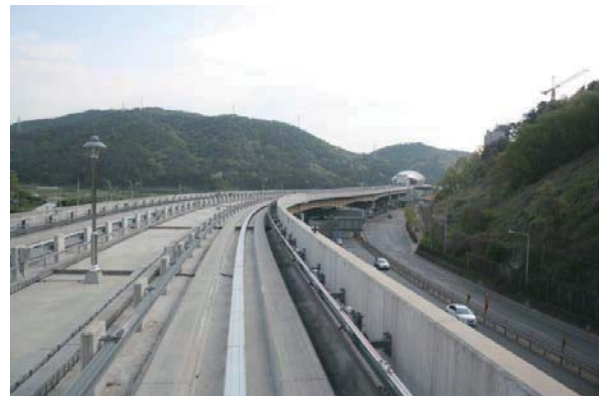
Gwang-myeong LRT Project (Korea) - Total Length : 10.243km, Station : 8ea, Depot : 1ea, Tunnel : 2ea
