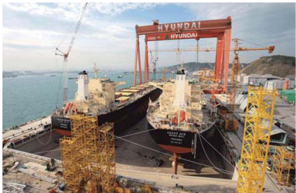
HHI H-Dry Dock Project (Korea)
